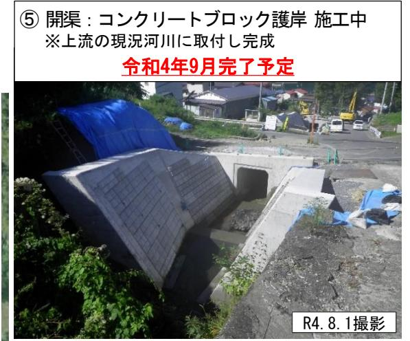
③ 開渠：コンクリートブロック護岸 施工中
