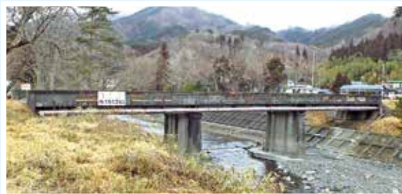
補修される日当橋
