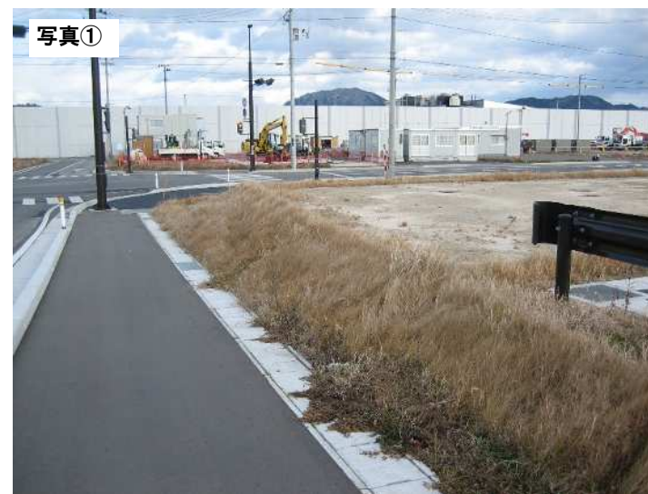
【現況写真 (令和2年1月撮影)】
