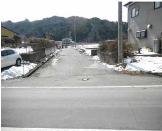
早急な整備が望まれる上地区の排水整備
