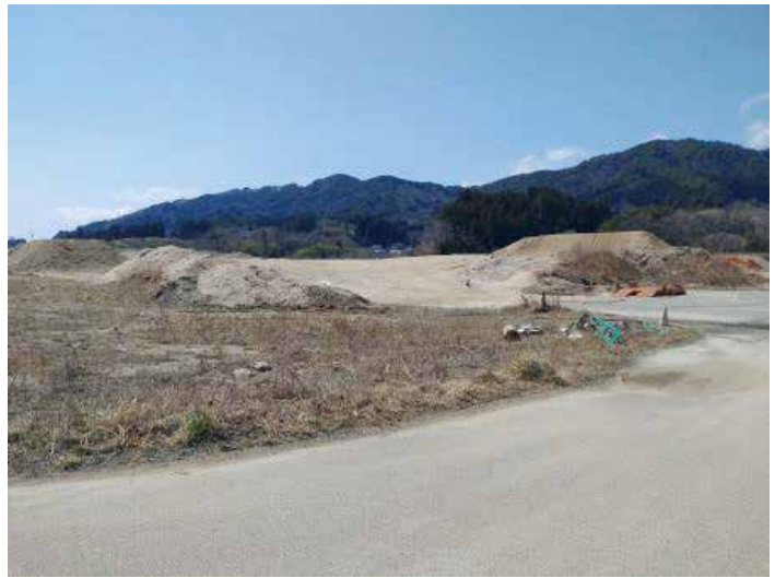
整備が進められている船越家族旅行村水辺公園内のパークゴルフ場予定地
