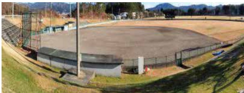
町民グラウンド（野球場等）を廃止し 山田小学校新校舎が建設される予定です
