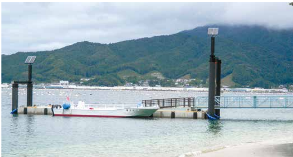
潮位変動に対応したオランダ島の浮き棧橋
