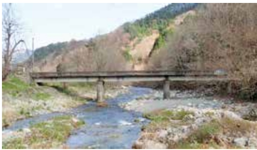
補修工事となる船石橋
