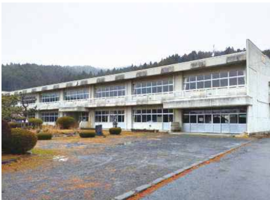
解体工事が決まった旧山田町立大沢小学校
