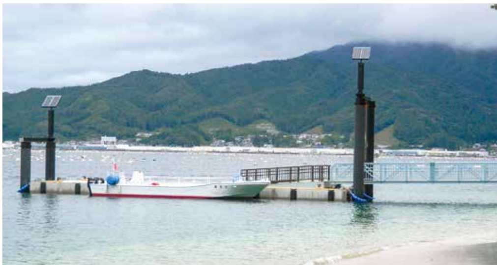
潮位変動に対応したオランダ島の浮き棧橋
