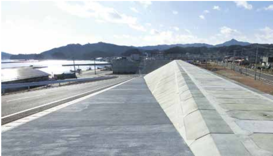
手すりや街灯の設置が待たれる防潮堤上部
