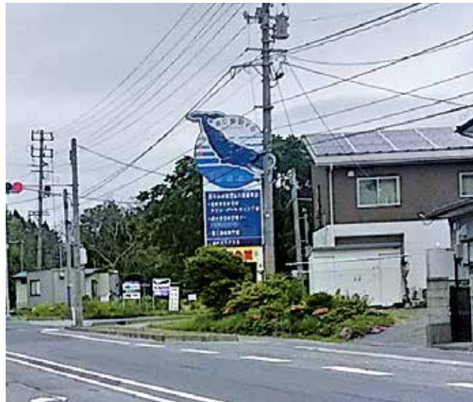
補修が必要な案内板
