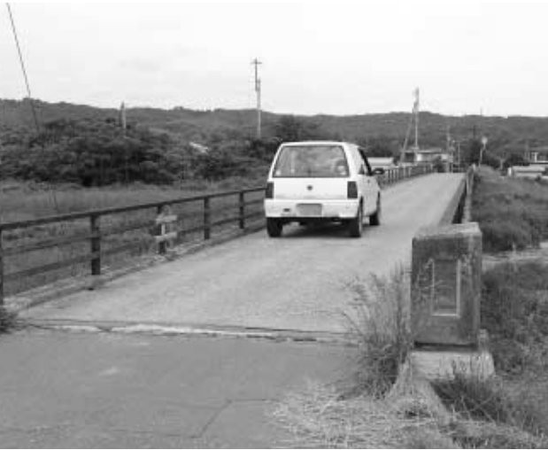
来年度改修予定の石峠橋
