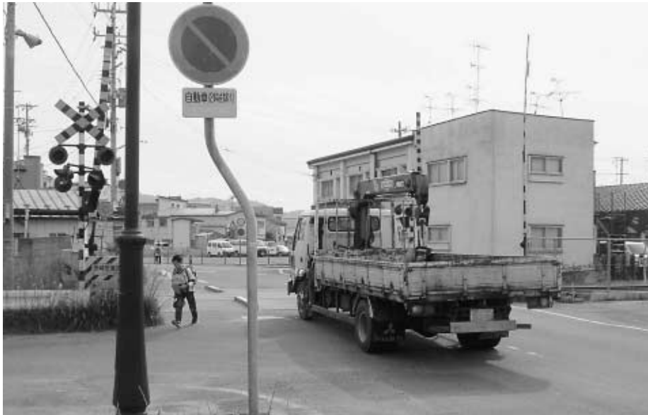
改良が望まれる長崎街道踏切
