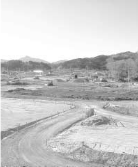
厳しい財政状況により工事のおくれが心配「柳沢北浜地区土地区画整理事業」
