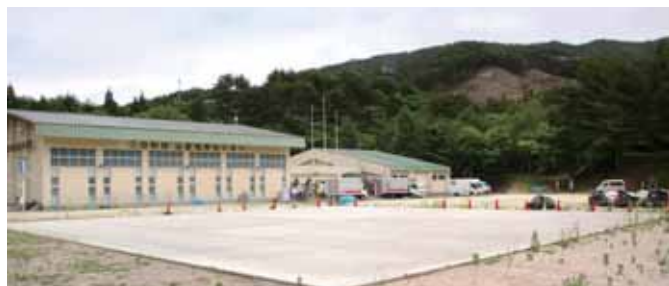
B & G 体育館前に建設されたヘリポート
