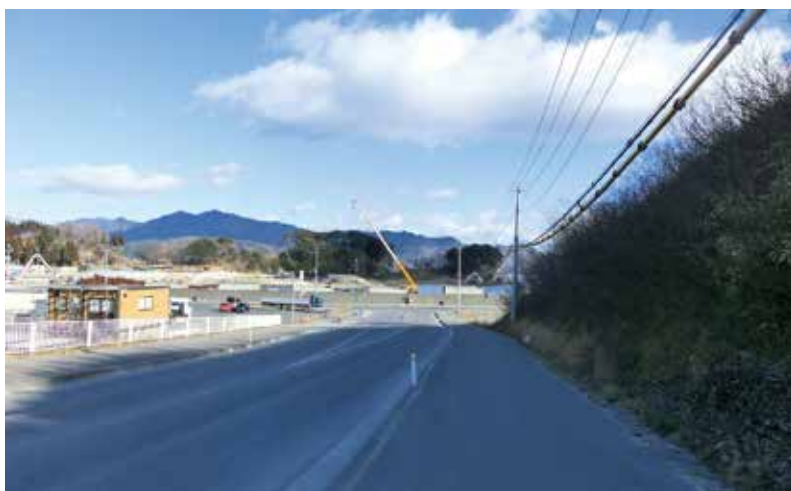
信号機設置が望まれる山田高校入口付近
