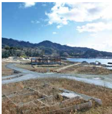
仮設道路建設予定の前須賀地区
