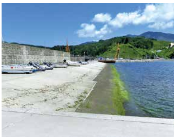
勾配の改良が望まれる北浜船揚場
