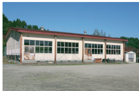
山田中学校に新しい武道場が建設されます（現在の格技場）
