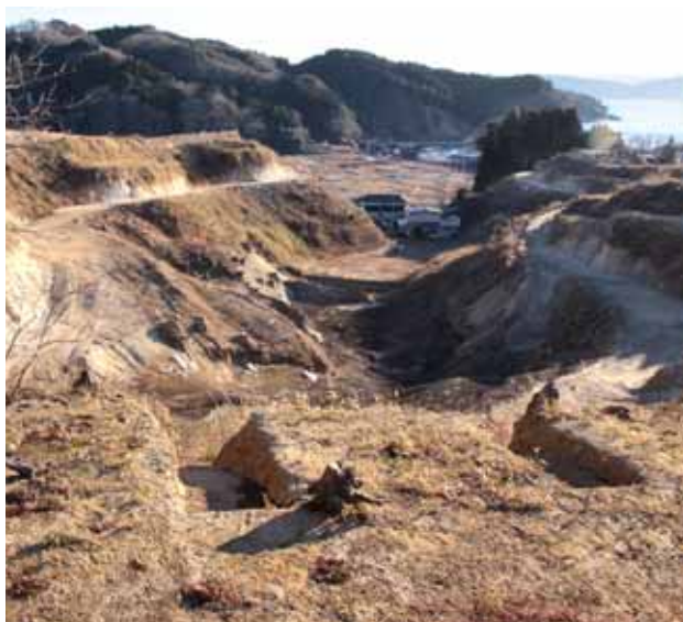
造成中の船越・田の浜地区の高台住宅団地用地
