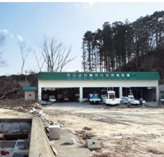
復旧予定のB & G海洋センター艇庫
