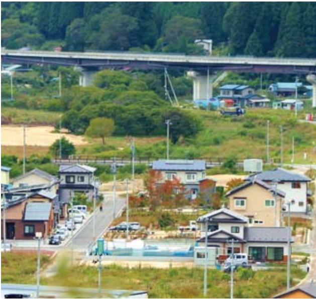
住宅再建が進んでいます（柳沢地区）
