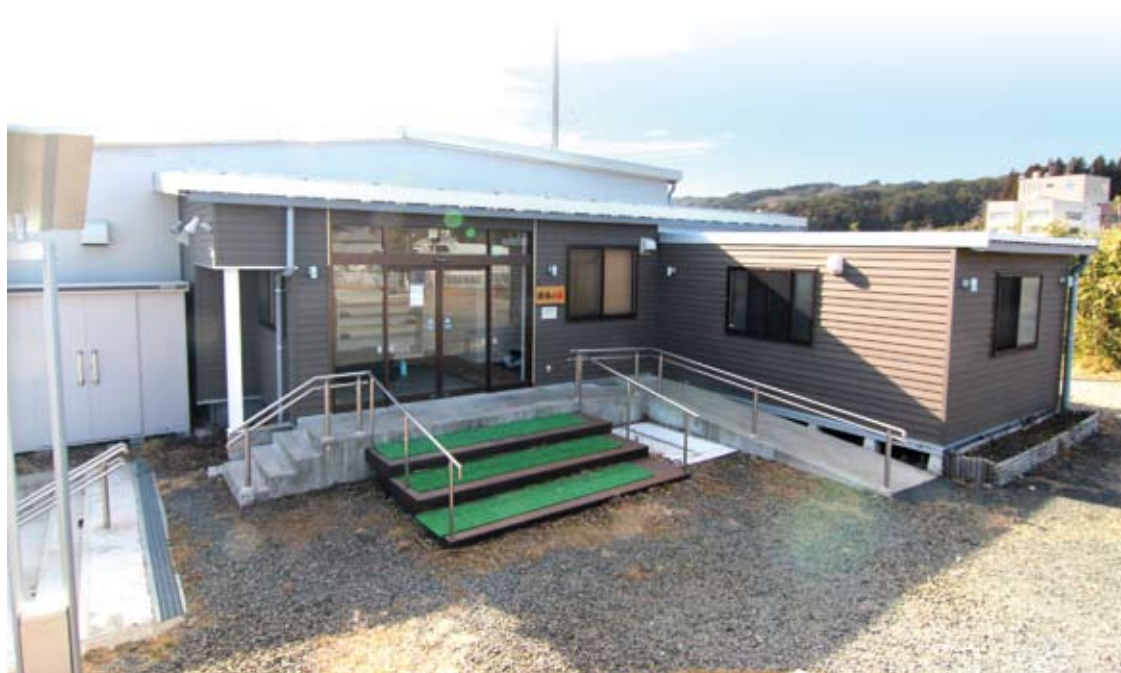
御蔵の湯の建物は解体される予定です
