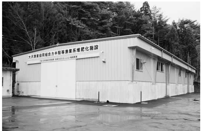
大沢漁協で整備した漁業系廃棄物堆肥化処理施設
