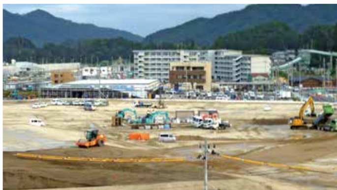
工事が進む山田地区の中心部
