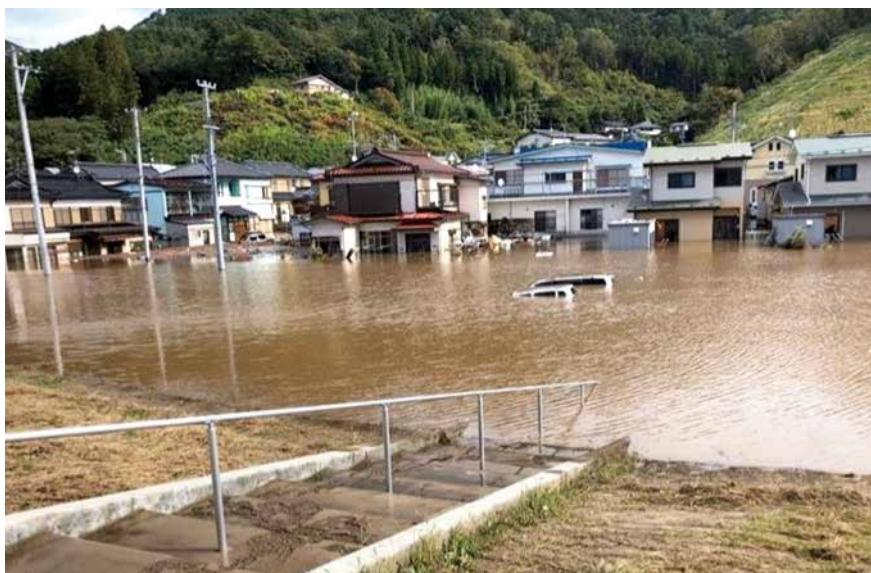
田の浜地区の冠水被害状況
