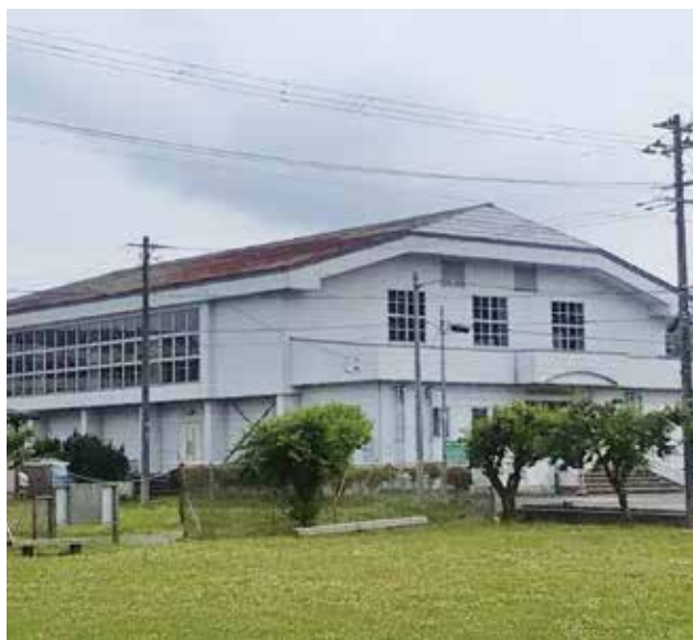
屋根の補修が待たれる健康増進センター
