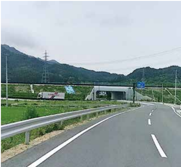
フル化に向けて共通認識の必要な山田北インター
