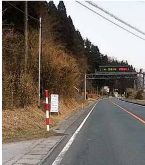
工事が進む大沢地区の国道45号
