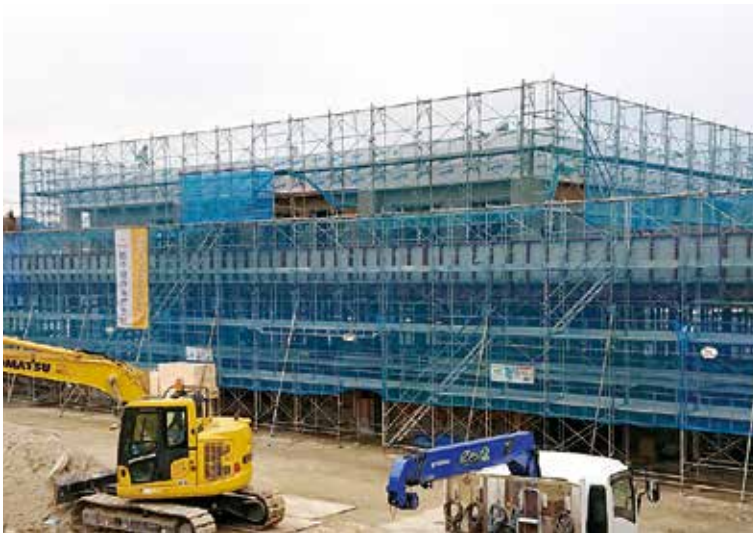
来年4月の供用開始に向け工事が進む給食センター
