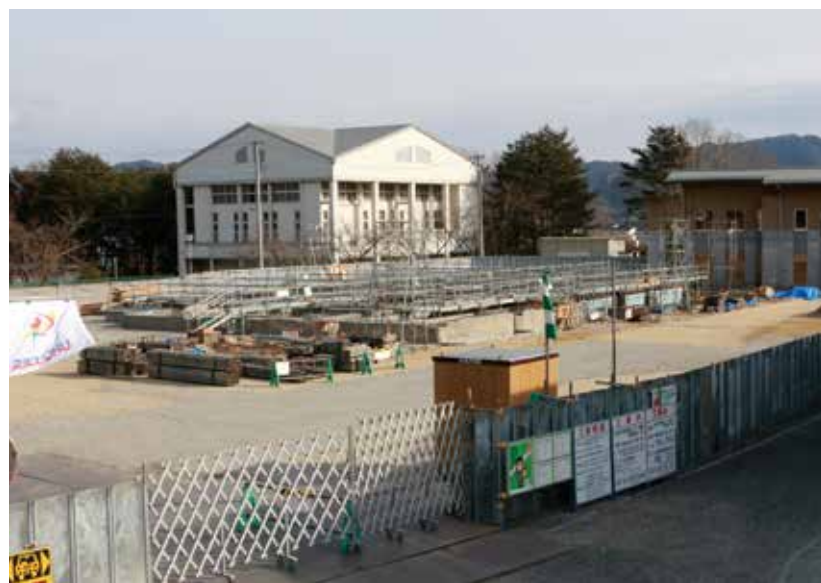
建設が進む給食センター (31年1月)
