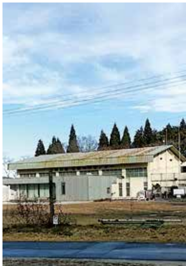
補修が必要なB & G体育館
