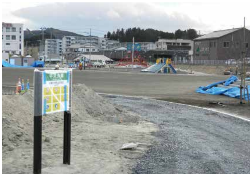
整備が進む中央公園
