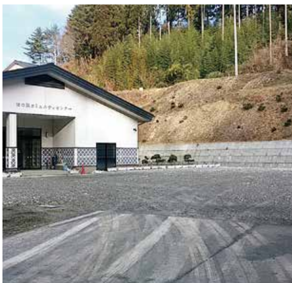
早急に駐車場の舗装整備が必要な田の浜コミセン
