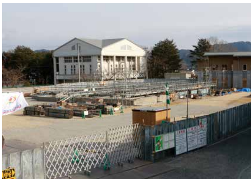
建設が進む給食センター (31年1月)
