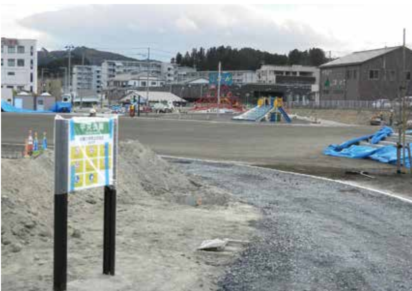
整備が進む中央公園
