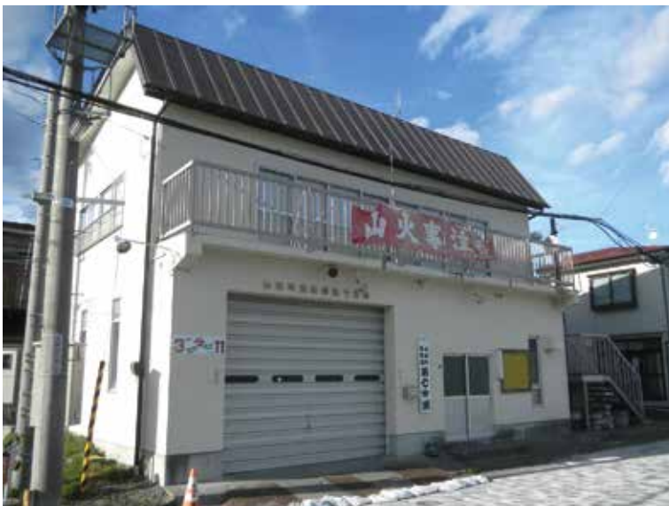
整備が完了した第7分団屯所
