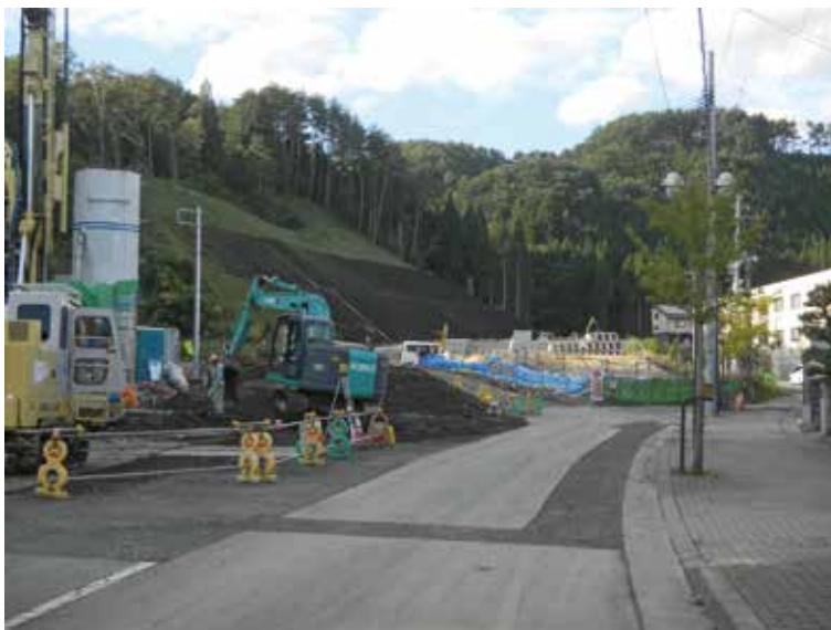
施工中の町道細浦柳沢線
