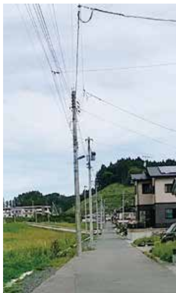
早急な移設が望まれる電柱
