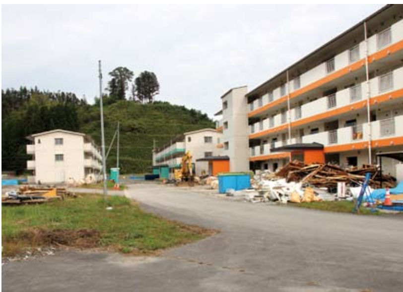
施工中の柳沢団地被災者向け公営住宅
