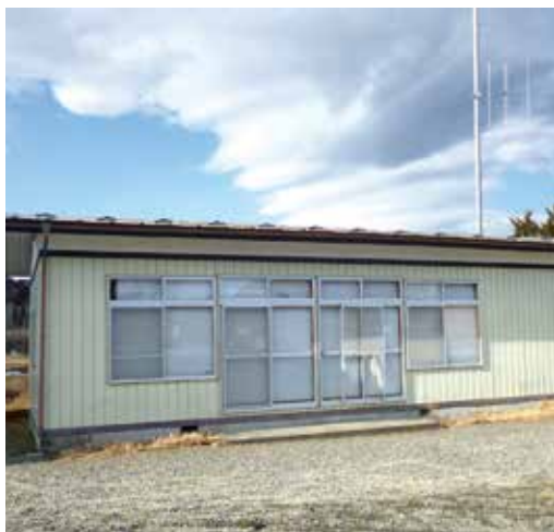
解体前の白山コミュニティセンター
