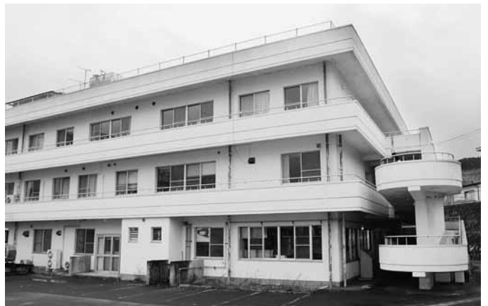
図書館などへの活用を図るため医療局と協議が進められている「旧県立山田病院」の増築棟側
