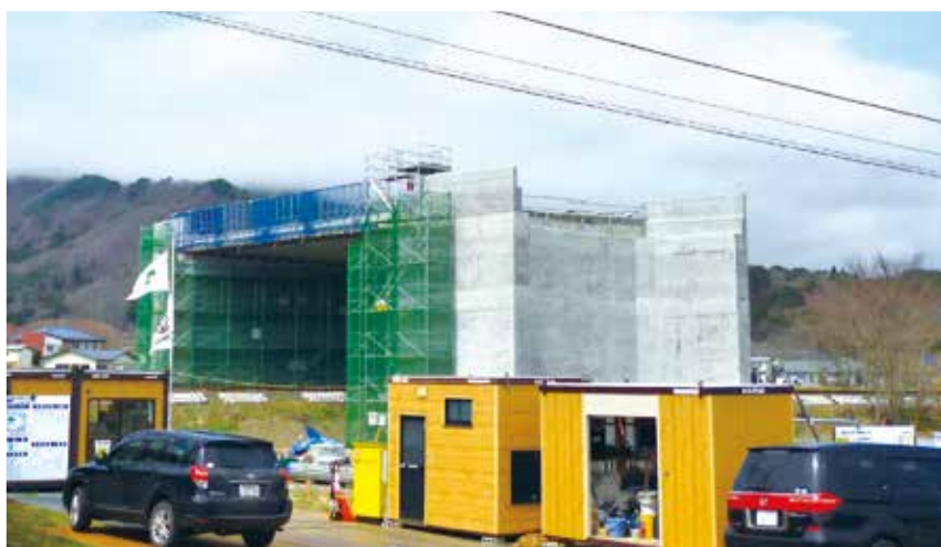
工事が進む県道宮古山田線
