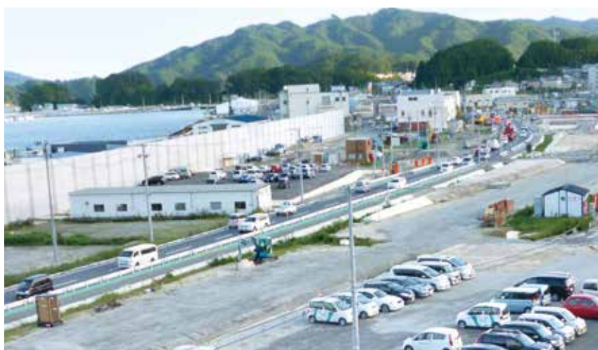
整備が進む国道45号
