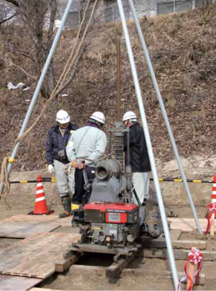
高台移転候補地のボーリング調査（織笠地区）
