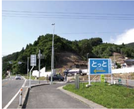
工事中の大沢地区高台団地への工事用道路
