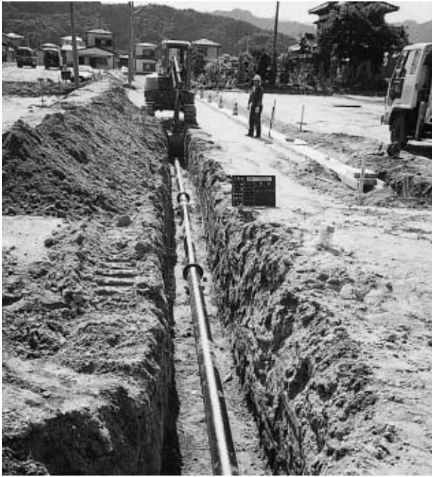
水道管布設の様子（柳沢北浜地区土地区画整理地内）
