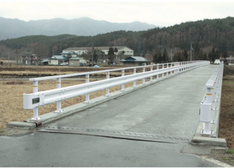
橋梁補修事業により補強工事がされた中村橋（豊間根地区）
