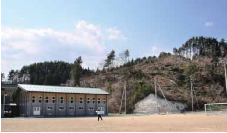
伐採中の県立山田病院整備予定地
