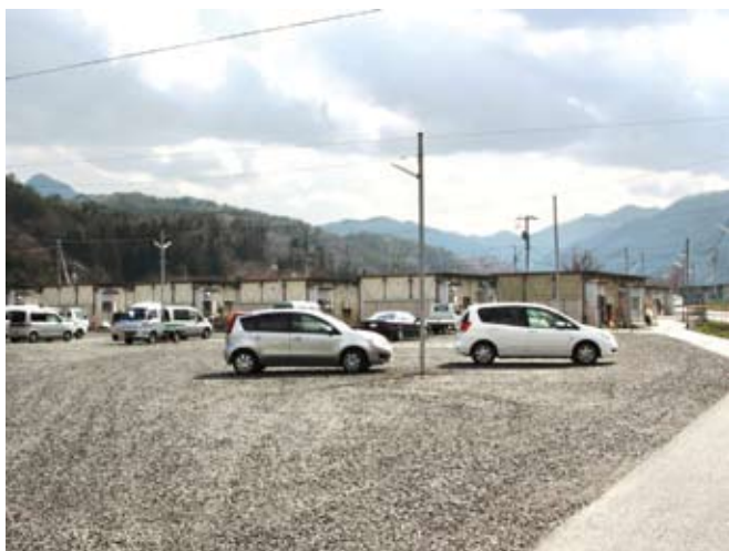
借地に建つ仮設団地
