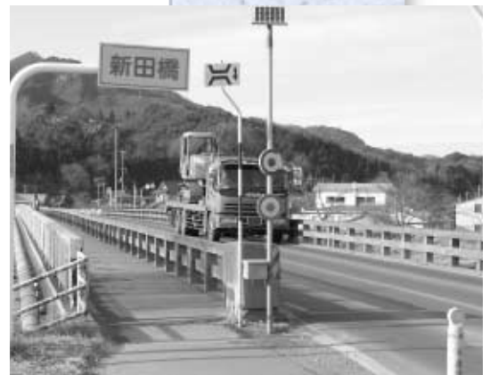
機能強化として耐震補強が図られることとなった豊間根新田橋
