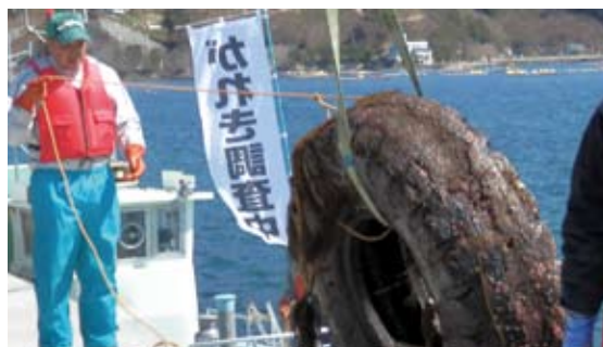
がれき撤去作業
