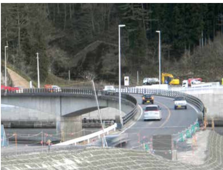
織笠大橋の歩道設置は町民の悲願
