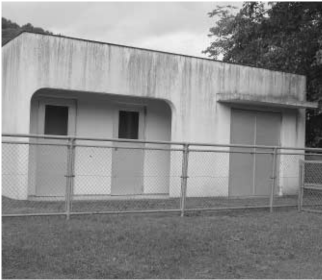
馬指野簡易水道は、織笠上水道と接続するための工事が平成19年度から始まります（馬指野簡易水道施設）
