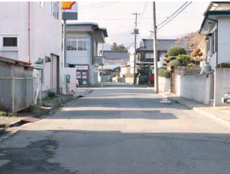
大浦簡水石綿管の布設替えに併せて、本通り線の舗装整備が望まれています
