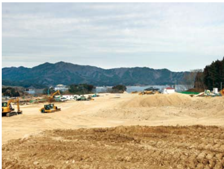
造成中の織笠地区高台住宅団地
