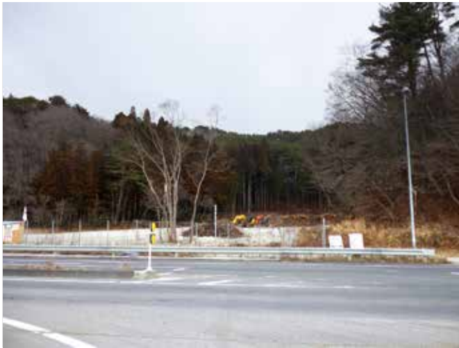
新斎場敷地造成工事
